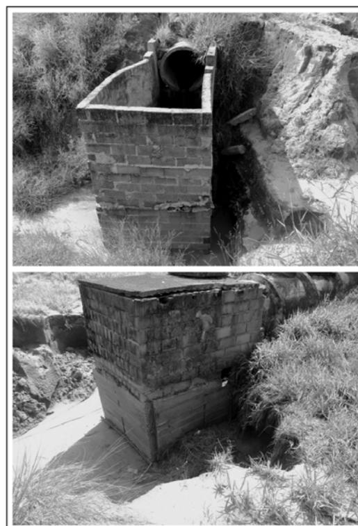
**Figura 5a e 5b – Poços de visita com degrau próximos ao emissário: da “rede sul” e “rede norte”, respectivamente, apresentando danos em função da erosão diferencial no contato da estrutura com os solos devido ao transbordamento**
