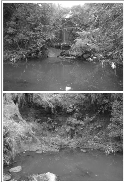
Fig. 6a e 6b - Ponto de deságüe do emissário da Rede Sul com formação de lagoa e solapamento das margens, respectivamente
