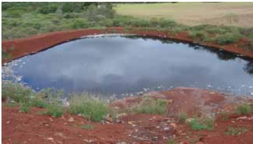
célula de resíduos em operação. Esta lagoa não possui barreira de impermeabilização de fundo e nem descarga para corpo receptor, o que constitui um risco à contaminação subterrânea. A Figura 3 apresenta uma vista da lagoa de contenção de lixiviado.
