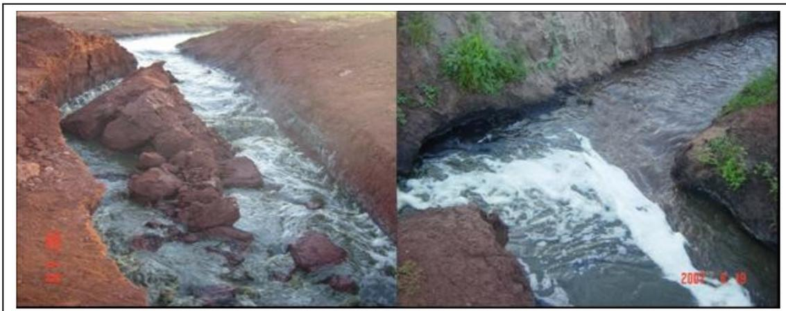
Figura 3 – Canais de condução de vinhaça apresentando desmoronamento e infiltração
