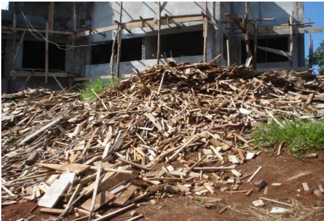
Figura 5 – Resíduos sólidos gerados durante a fase de realização da obra.
