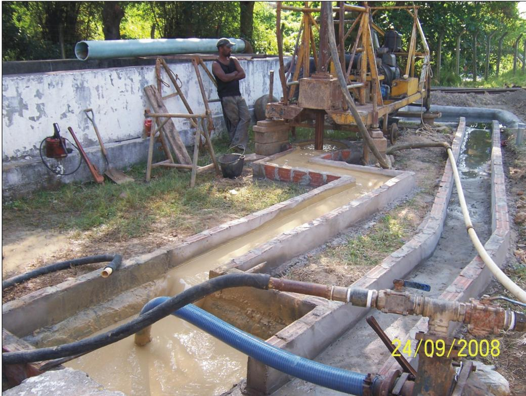
Figura 7 - Perfuração do poço de produção na E.E. Caixa d' Água.
