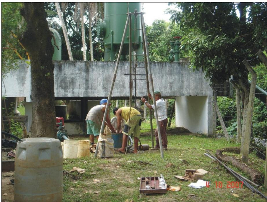
Figura 4 - Realização dos furos de sondagem, método de percussão (SPT).
