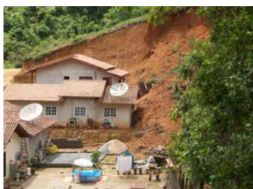
Figura 32 - Corte íngreme de talude
