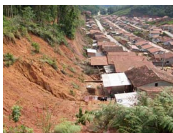
Figura 33 - Queda de taludes
