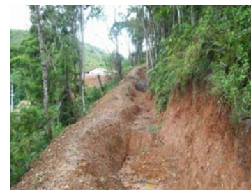
Figura 34 - Drenagem no talude
