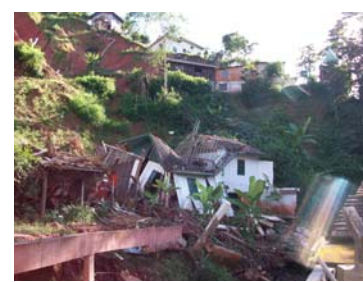
Figura 55 - Destruição de casas
