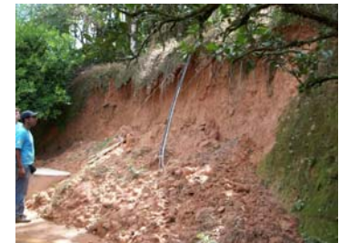
Figura 46 - Talude de corte
