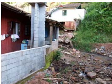
Figura 50 - Casa na divisa do córrego
