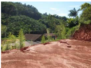
Figura 20 - Corte da encosta
