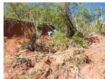
Figura 22 - Instabilidade da encosta
