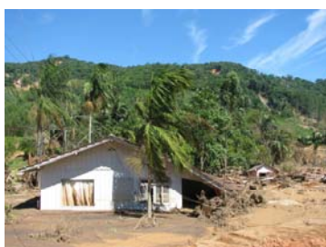
Figura 24 - Soterramento de casas
