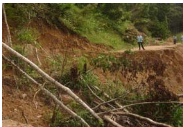
Figura 15 - Obstrução da estrada
