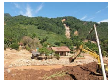
Figura 25 - Desobstrução do rio
