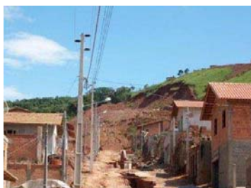
Figura 36 - Erosão nas ruas
