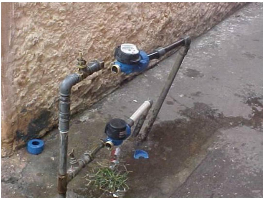
**Foto 05 – Ligação de água desconectada durante o teste**
