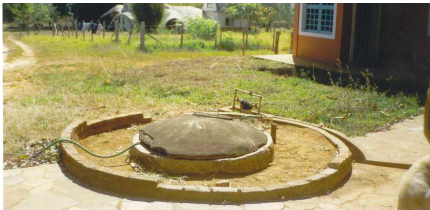
Figura 7 – Poço escavado (cacimba) (Foto: Viero, 2005)
