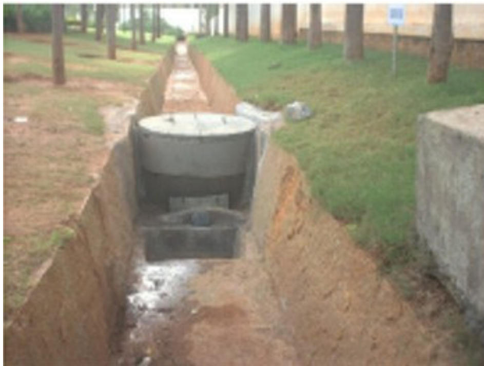
Figura 11 - Poço de recarga do lençol freático em Bangalore, Índia (Modificado de Gnadlinger, 2004)
