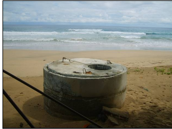
Figura 7. Estação elevatória de água do mar
