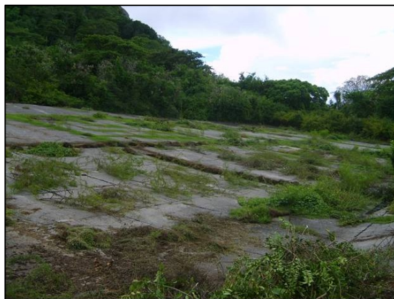
Figura 05- Placas de captação
