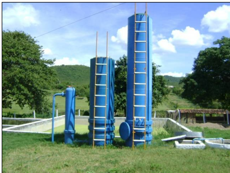
Figura 01 – Reator Anaeróbio de Fluxo Ascendente – RAFA – ETE Mutuca. Instalado pela Universidade Federal Rural de Pernambuco ( Montenegro et al 2008 )
