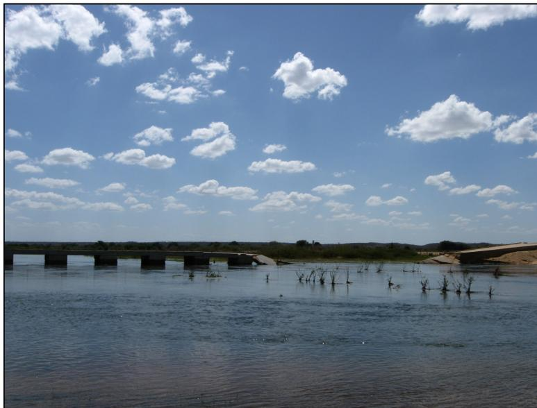
Figura 4 – Passagem Molhada de São João (trecho 2), tipo concretada com pilares. Inaugurada no segundo semestre de 2007 e destruída durante as chuvas de 2008. Foto do autor (18-12-2008).
