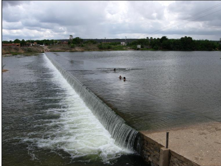
Figura 3 – Passagem molhada de Quixeré (trecho 3), tipo concretada sem manivas (anéis de concreto tipo tubulações). Observar lâmina d'água passando por cima do barramento (período de estio). Foto do autor (20-01-2009).
