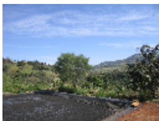
Figura 5: Lagoa (esterqueira) existente na propriedade antes da instalação do biodigestor
