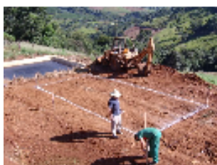
Figura 6: Início da terraplenagem na propriedade para instalação do biodigestor protótipo
