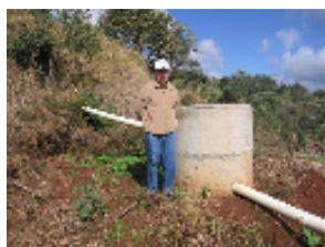
Figura 8: Detalhe da caixa de distribuição de dejetos (entrada do biodigestor)
