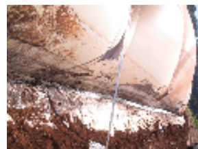
Figura 7: Detalhe do acúmulo de água em função do assentamento do solo
