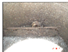
Figura 8: Detalhe da caixa de distribuição de dejetos (entrada do biodigestor)
