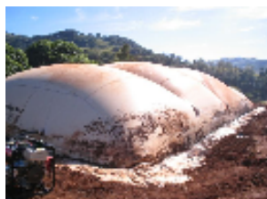
Figura 7: Detalhe do acúmulo de água em função do assentamento do solo
