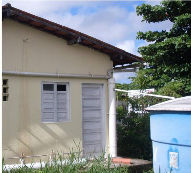
Figura 1 - Estrutura de captação, transporte e armazenamento da água de chuva.
