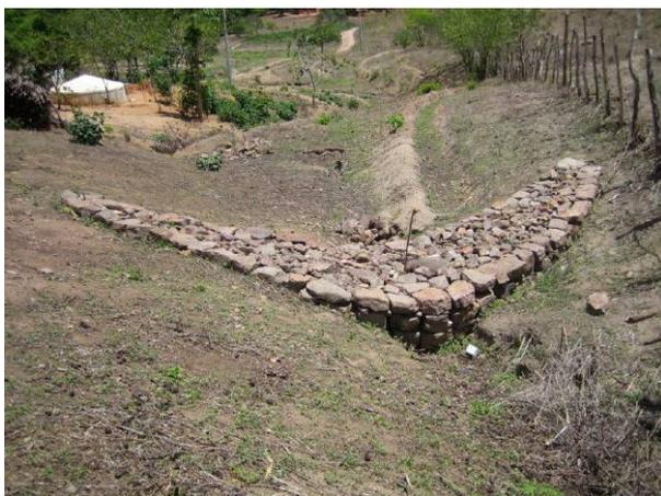
(a) Microbarragem de contenção de sedimentos
