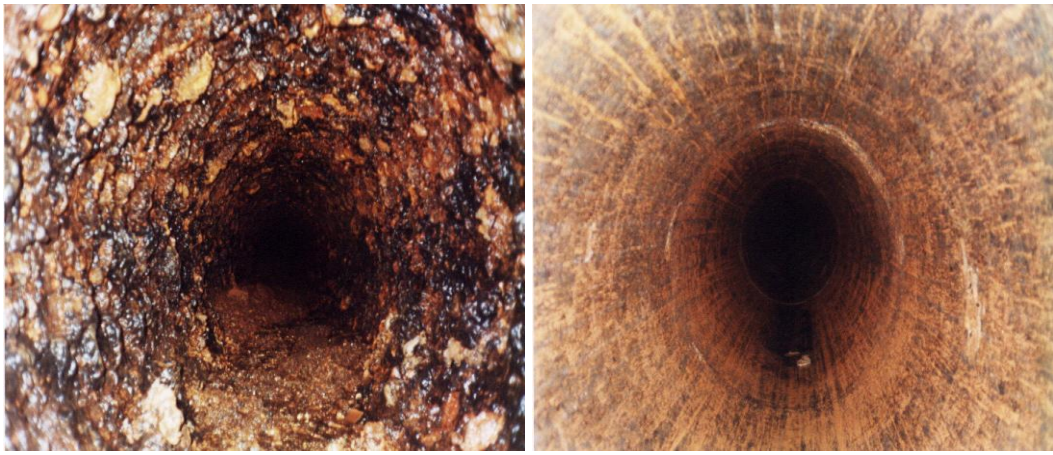
Figura 10 – Estado da Tubulação antes e após a passagem de Pigs (Fonte: Hidropig/2009)
