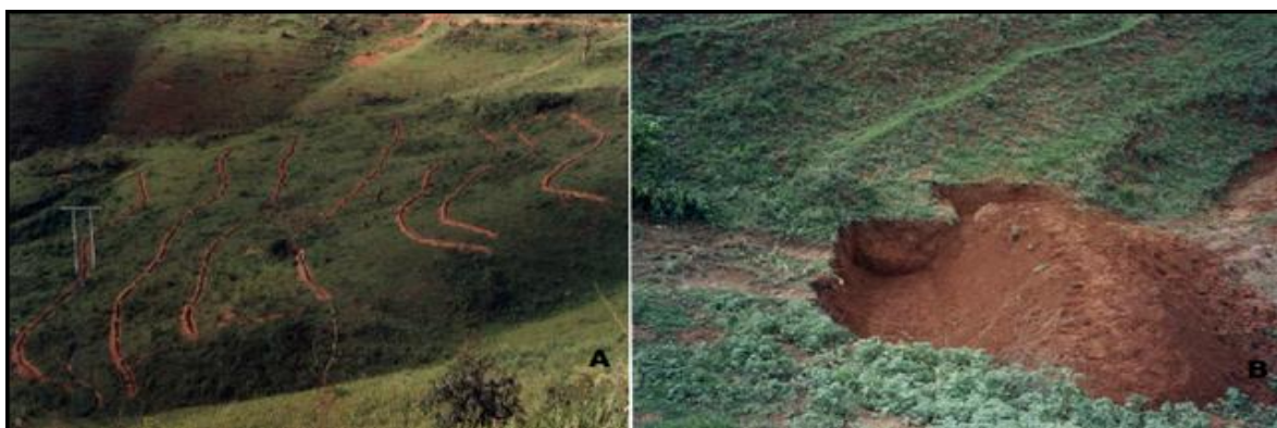
Foto 01 – Estruturas de contenção do fluxo superficial (Gomes, et alli)
