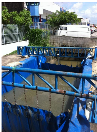
Figura 7 - Barragem no canal do Vasco da Gama – Arruda.
