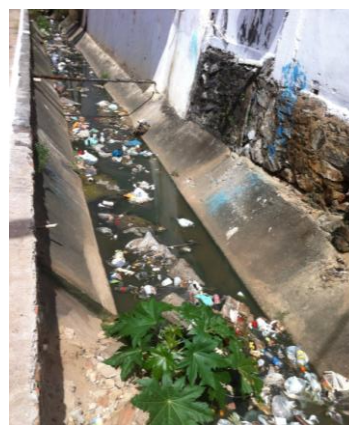
(b) Disposição de Resíduos sólidos.
