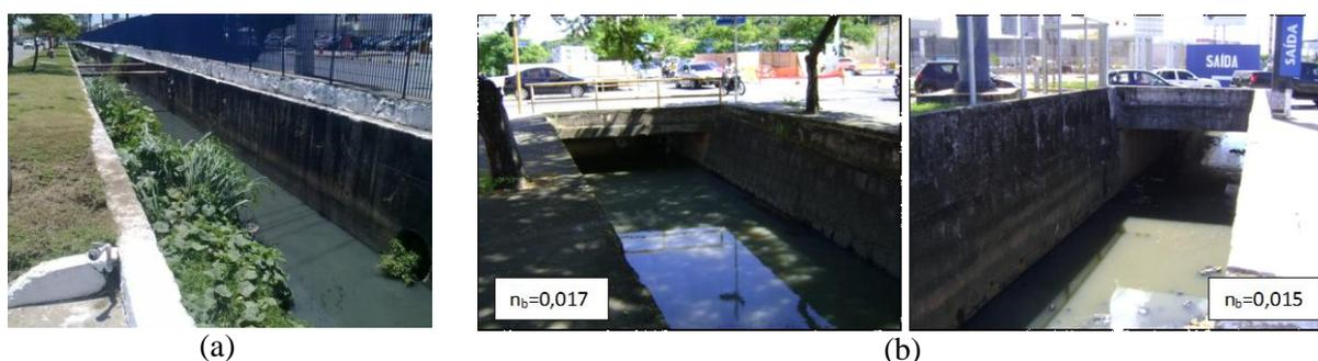
Figura 4 - Tipos de revestimento encontrados ao longo do canal para a composição do  $n$  de Manning.
