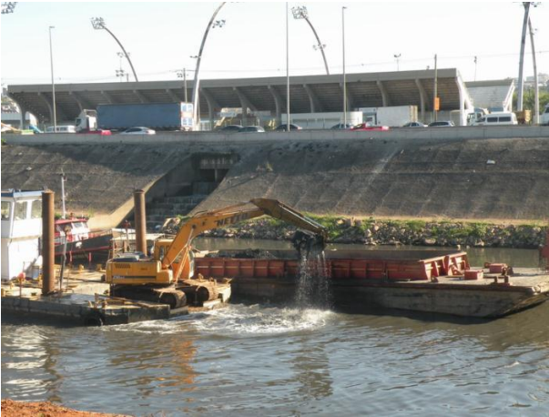
Figura 2. Intervenção pelo leito fluvial, por meio de escavadeira embarcada, no rio Tietê (2011).
