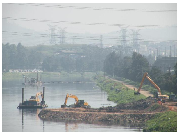
Figura 4. Plataforma embarcada (à frente) e draga de sucção e recalque (ao fundo) em operação, no rio Pinheiros.
