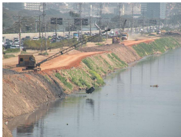
Figura 5. Intervenção a partir da margem, por meio de Dragline , no rio Pinheiros (2012).
