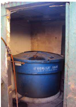
Figura 4 – Reservatório de água potável usada atualmente na lavação de veículos - local para a implantação do proposto reservatório de água da chuva
