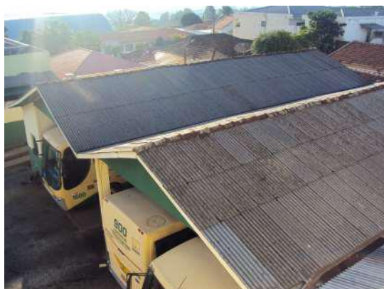
Figura 2 - Cobertura existente - possibilidade de utilização como área de captação da chuva na empresa
