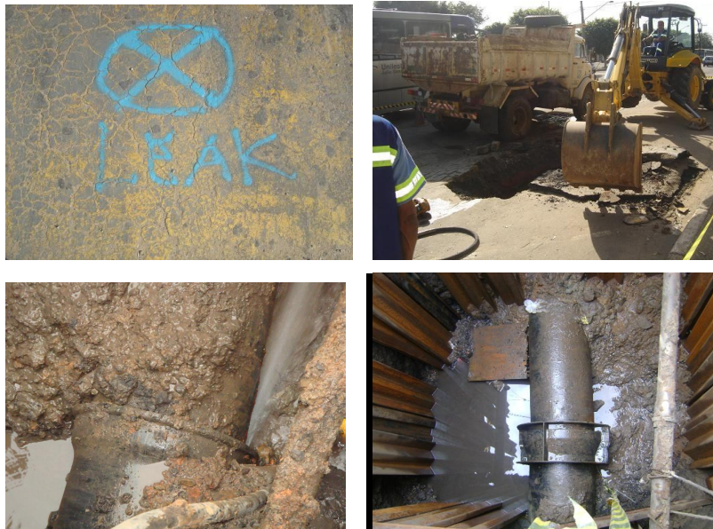
Figura 6 - marcação no solo, escavação, localização do vazamento e reparo em carga
