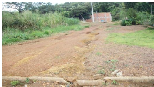
Figura 2. Construção civil próxima à vegetação.
