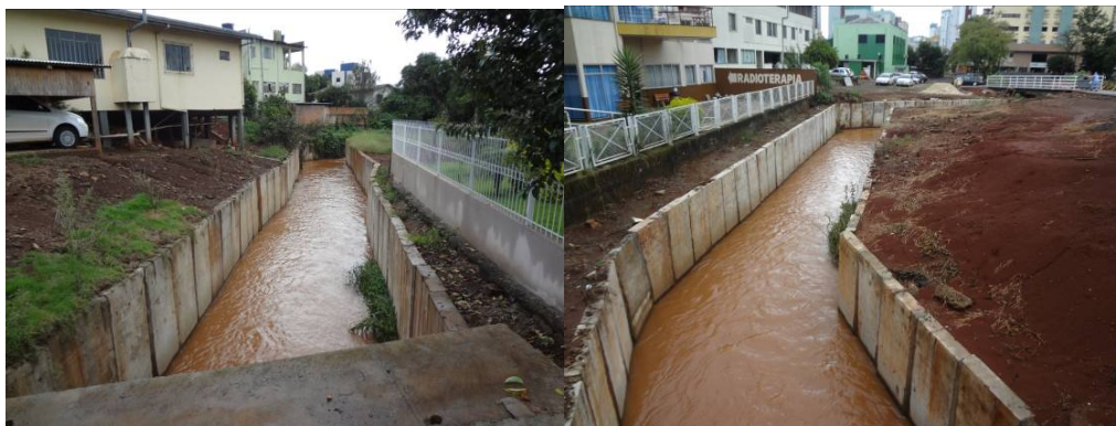
Figura 6 – Nova canalização do Córrego Fundo e as edificações inseridas no fundo de vale.
