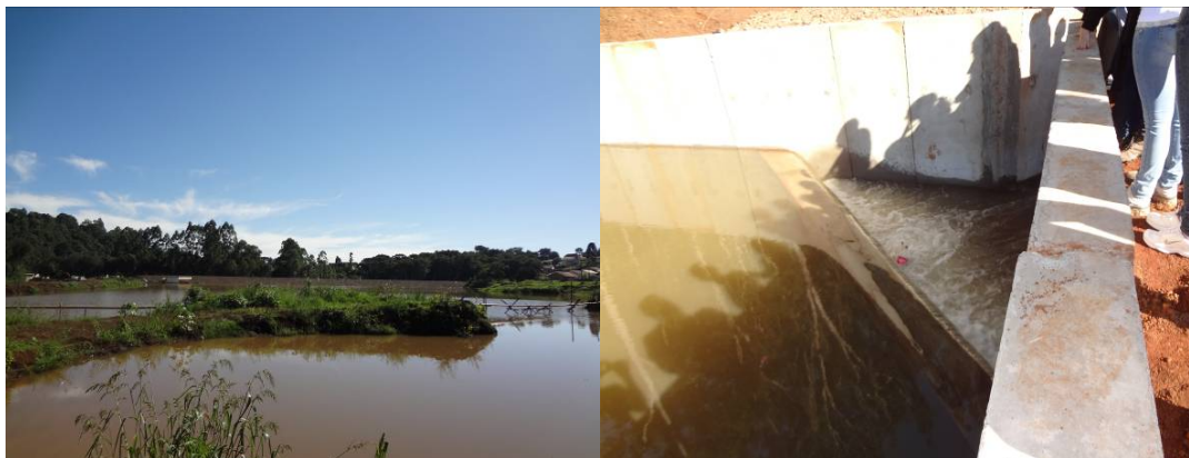
Figura 7 – vista do lago de inundação com a construção da barragem e o vertedor para a vazão ecológica.
