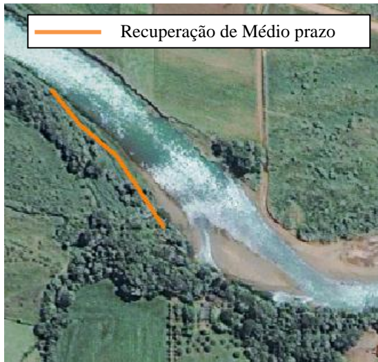
Figura 5 - Local que requer recuperação/intervenção em médio prazo
