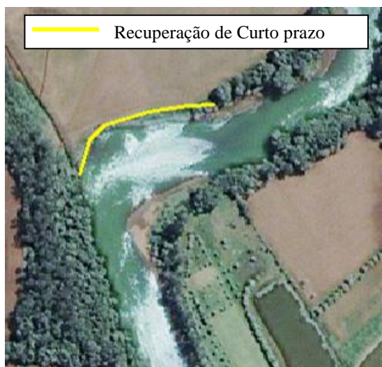
Figura 4 - Local que requer recuperação/intervenção em curto prazo
