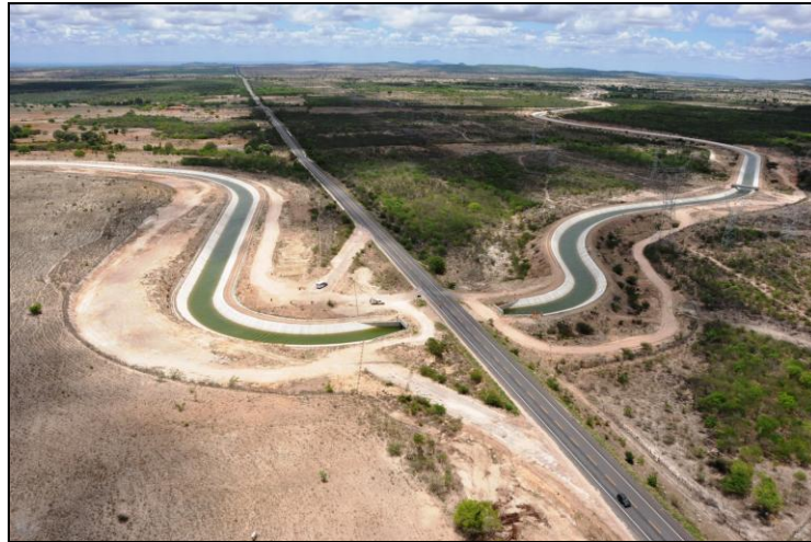
Figura 2 – Vista panorâmica do Canal do Sertão Alagoano
