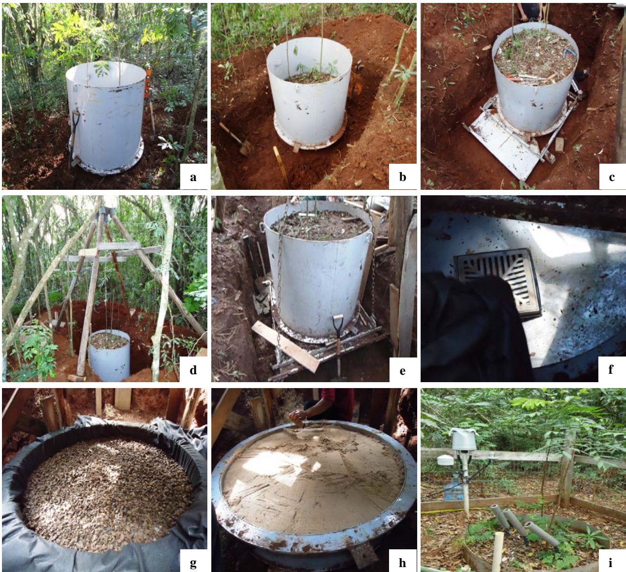
Figura 3 – Fases de instalação do lisímetro de drenagem na área de mata nativa: a. escolha do local de instalação; b. abertura da trincheira; c. introdução das lâminas e corte do solo; d. montagem da estrutura para elevação do lisímetro; e. lisímetro sendo suspenso; f, g, h. confecção do filtro; i. lisímetro já instalado, com tensiômetros instalados e vegetação interna original e intacta.
