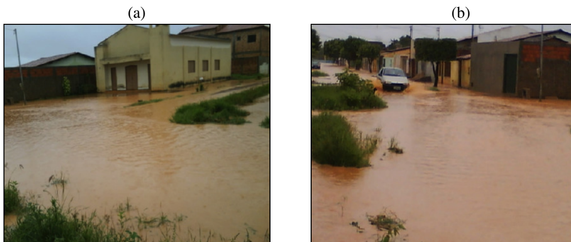
Figura 1 – (a) e (b) Situação encontrada na Rua Uberada, bairro São Paulo em dias com chuvas - Fonte: mais.uol.com.br.
