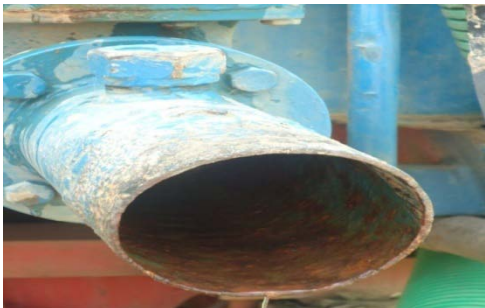
Figura 1 – Mostra a dificuldade do fornecimento de água a população.
