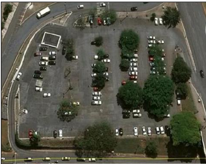
Figura 1 - Reservatório subterrâneo Off-line, localizado sob estacionamento próximo ao shopping Conjunto Nacional, Brasília-DF - SITUARE, Arquitetura + Engenharia
