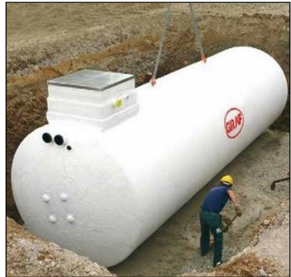
Figura 2 - Reservatório subterrâneo Off-line - GRAF. Cuves en acier . 2009
