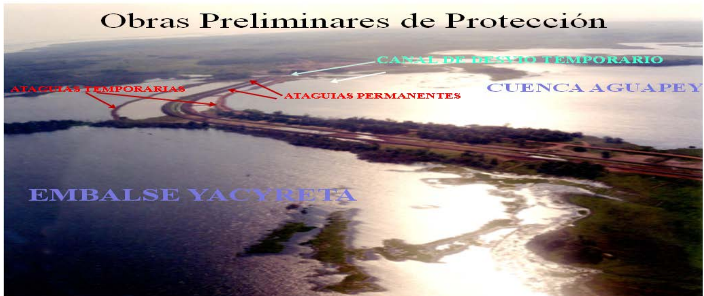
Figura 2 – Fotografías - Ataguías permanentes y temporarias
