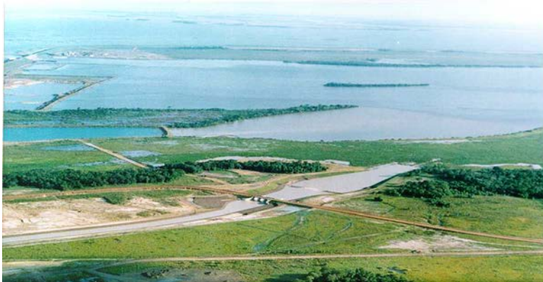
Figura 6 - Estructura de Entrega y Canal de Drenaje PLD - Vista
