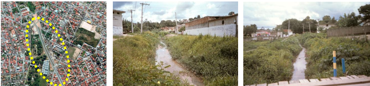
Figura 3 – Imagem de satélite do trecho alvo de estudo (posterior às obras) e fotos do local antes da intervenção
