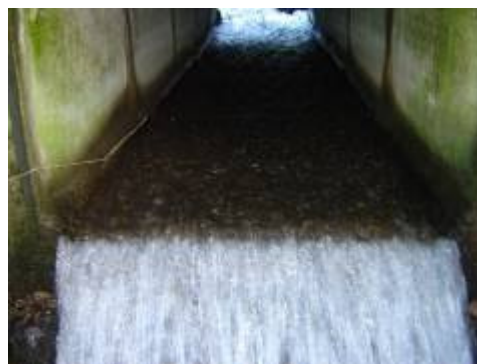
Figura 1- Exemplo de um Bueiro Caixa intransponível.
