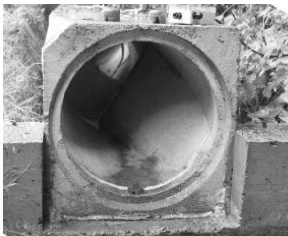
Figura 2 – Defletores intercalados por módulo de bueiro.
