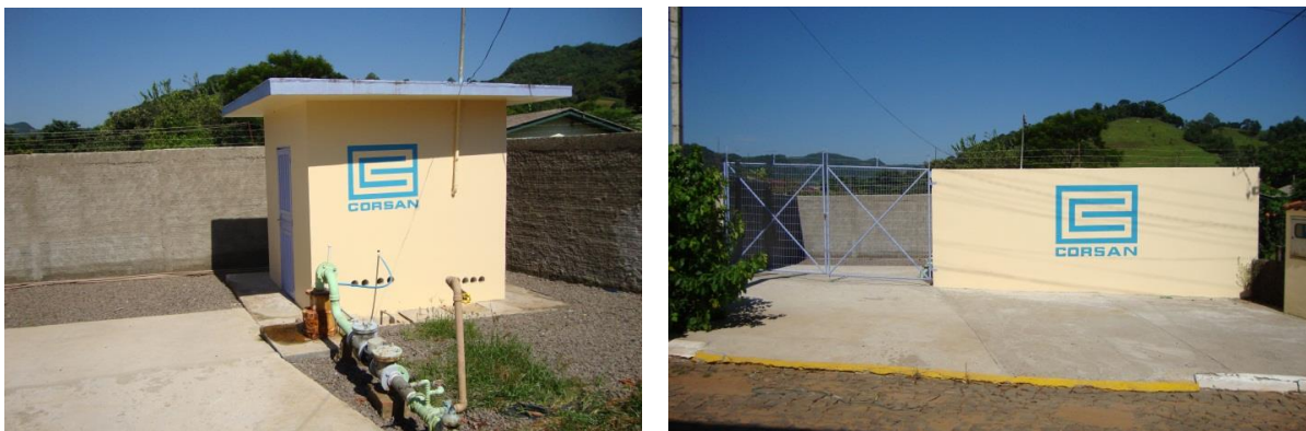
Figura 2: Imagem do poço 4300007677/SIAGAS/CPRM, localizado na área urbana do município de Nova Palma. Fonte: trabalho de campo realizado em Janeiro de 2013.
