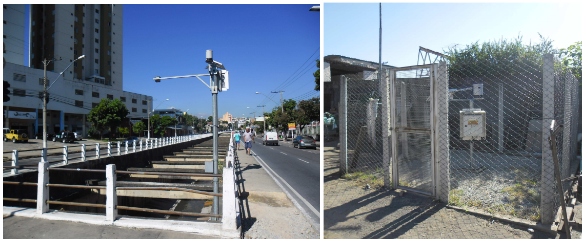
Figura 1 – Estação Fluviométrica 13 – Córrego Cachoeirinha / Av. Bernardo Vasconcelos e Pluviométrica 14
