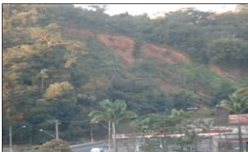
Figura 3 - Voçoroca em área central da cidade, Av. Castelo Branco.
