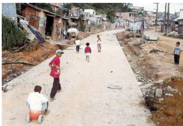
FIGURA 7 – Canalização do Córrego Imbuias - Guarapiranga- Recuperação Urbana do Município de São Paulo - 2000
