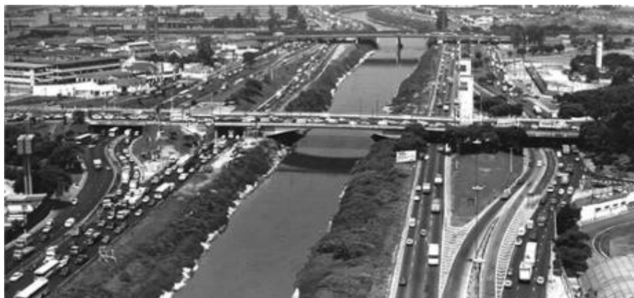
FIGURA 5 – Ponte das Bandeiras – vista atual - Vieira (2001).
