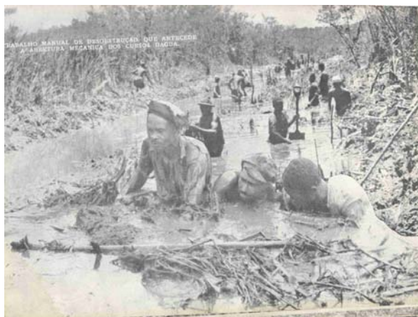
Figura 10 Trabalhadores limpando Rio Fonte. Saneamento da Baixada Fluminense
