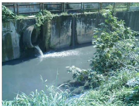
Figura 14. Esgoto in natura despejado no Rio Pavuna Meriti Fonte: Arquivo Pessoal
