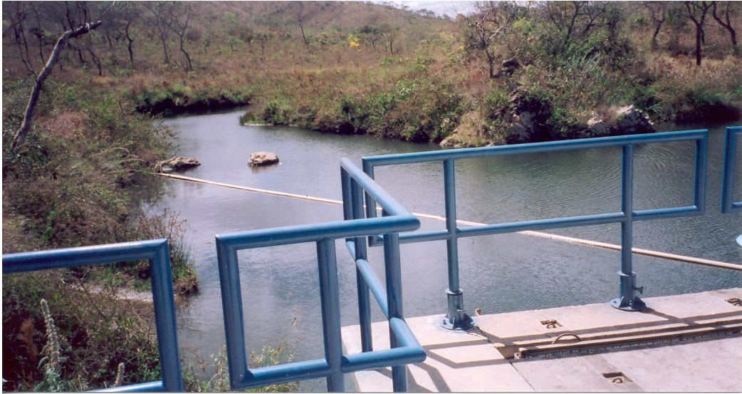
Figura 2 - Barragem e reservatório de derivação da ETA-Pipiripau (CAESB).
