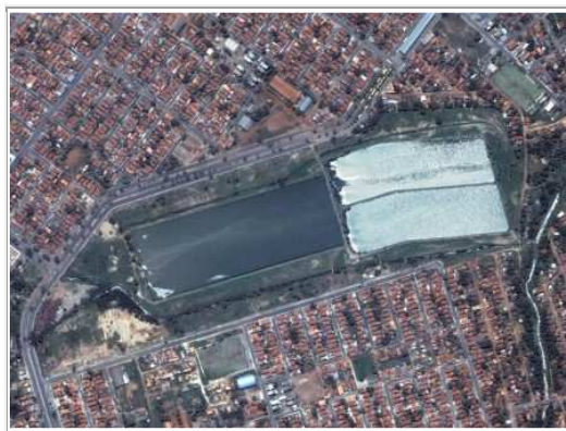
Figura 3.17 –Estação de Tratamento de Esgoto ETE CPA III – e o Projeto Implantação do Centro de Referência de Reuso de Água CRRA, (Fonte: adaptado do site CRRA )
