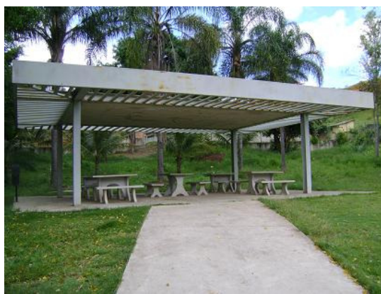
Figura 8 – Vista do Caramanchão na porção a montante do Parque.
