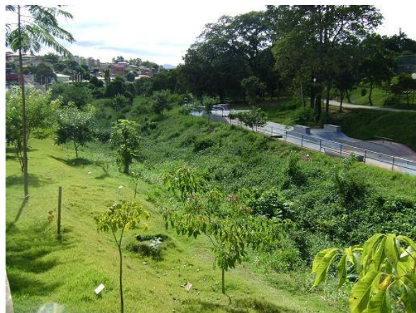
Figura 7- Vista da porção a jusante do pontilhão, com pista de skate na margem direita do córrego.
