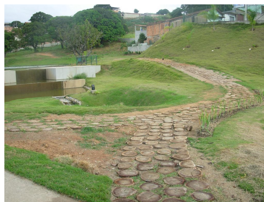
Figura 9 – Vista da pista de caminhada, construída a partir do reaproveitamento de madeira, a jusante do lago.
