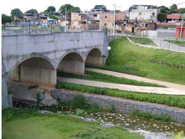
Figura 6 - Vista do pontilhão que garantiu a integração das duas porções do Parque.
