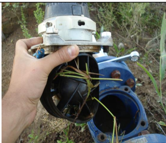
Figura 7 – Galhos trancando o hidrômetro
