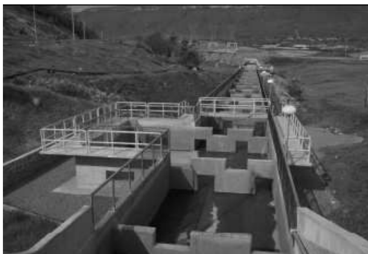
Figura 1: Escada de peixes do tipo piscina com vertedor na usina de Lajeado (Tocantins- Brasil)
