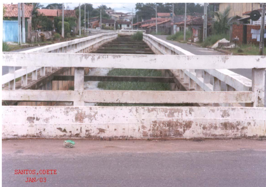
Figura 8 - Vista da Av. Paulo Titan, com um trecho do igarapé Castanhal canalizado. Fonte: SANTOS, O. C. de O. (2006)
