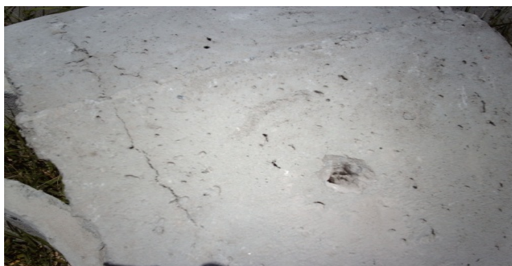
Figura 5 - Orifício feito para aumentar a infiltração de água no poço
