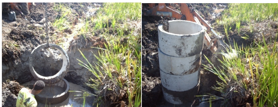
Figura 4. processo de construção e montagem do poço de FM
