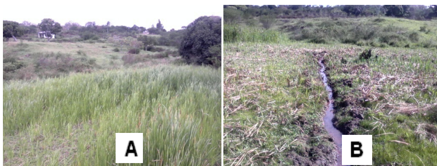
Figura 3. Área destinada para instalação do poço de Filtração em Margem (a). Após a capina construiu-se um dreno para remover o excesso de água (b) para permitir o trabalho das máquinas.
