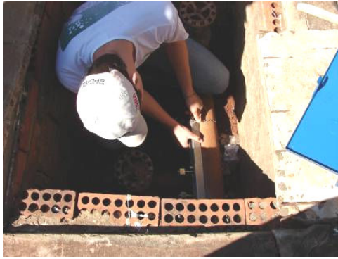
Figura 01 – Instalação do equipamento medidor de vazão
