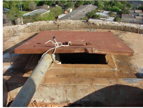
Figura 10 – Tampa de acesso ao reservatório Central.
