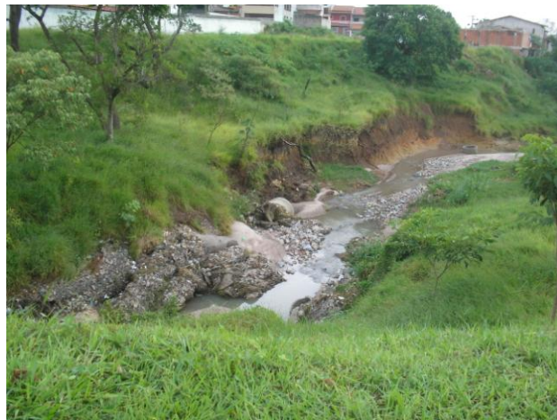
Figura 3.a – Vista de minibarragem construída no Córrego Senhorinha. Figura 3.b – Problemas de erosão de margem, com carregamento de gabião, verificado a jusante de minibarragem.
