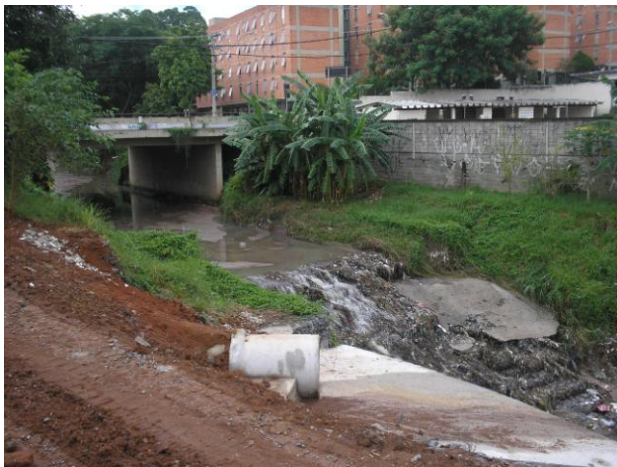
Figura 3.a – Vista de minibarragem construída no Córrego Senhorinha. Figura 3.b – Problemas de erosão de margem, com carregamento de gabião, verificado a jusante de minibarragem.
