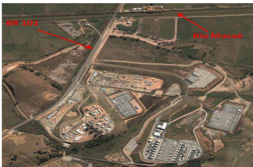
Figura 2 – Vista aérea da Termoeletrica Mário Lago e da região de estudo. Fonte: Google Earth.
