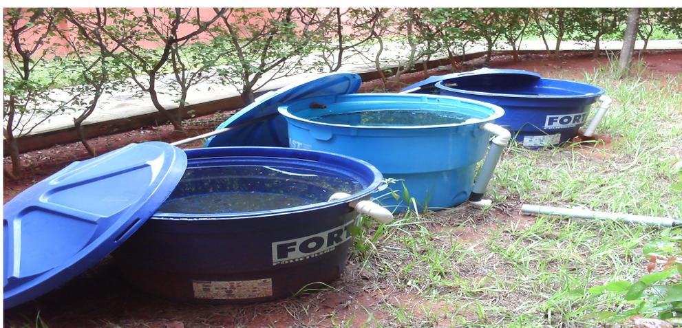
**Figura 02** - Reservatórios para armazenamento da água de chuva.
