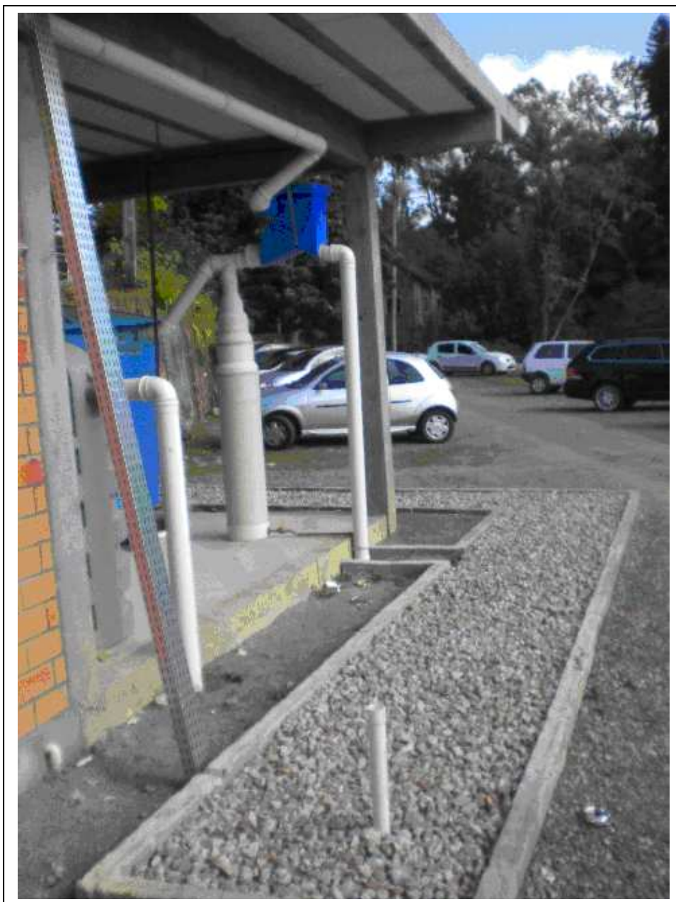
Figura 5 - Vista geral do sub-solo da Casa Modelo - FURB.
