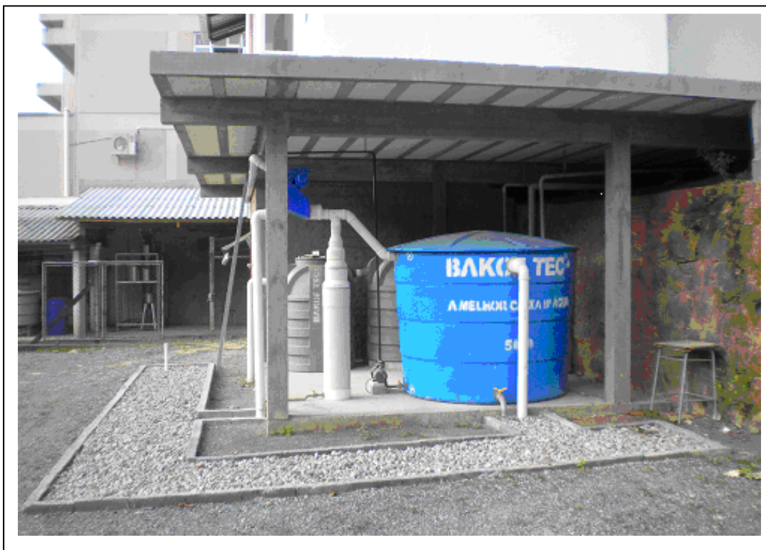
Figura 4 - Vista geral do sub-solo da Casa Modelo na FURB.
