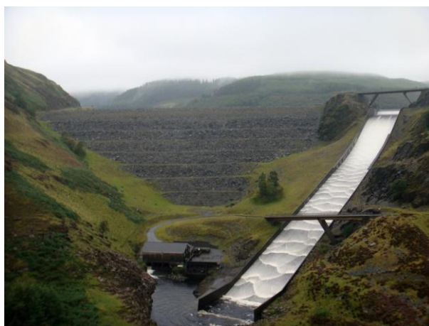
Figura 2 – Roll waves em vertedouro do reservatório de Llyn Brianne, em Wales, Reino Unido.
