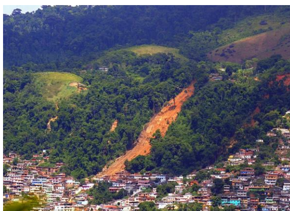
Figura 3 – Catástrofes naturais no Brasil: uma realidade. Na figura, deslizamento de terra em Angra dos Reis, Rio de Janeiro, formou um verdadeiro corredor, constituindo um canal inclinado natural com escoamento de material lamoso. O acidente, em Janeiro de 2010, acarretou mais de 20 vítimas fatais.
